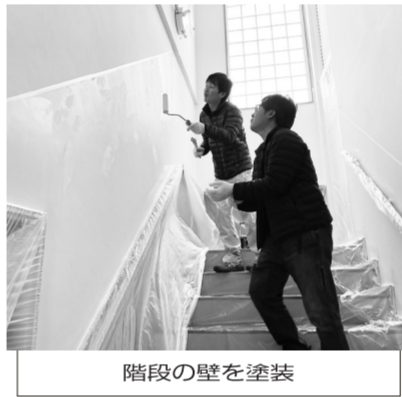
階段の壁を塗装
