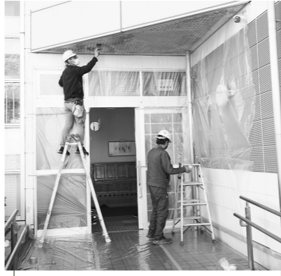
建物外部から作業開始
